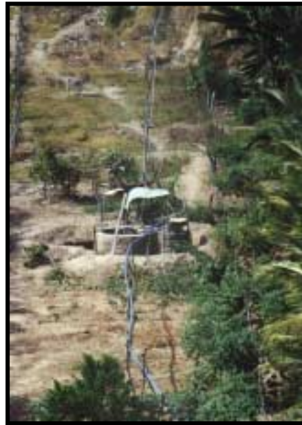
Foto 1 - Poço Amazonas - Mimoso/PE
